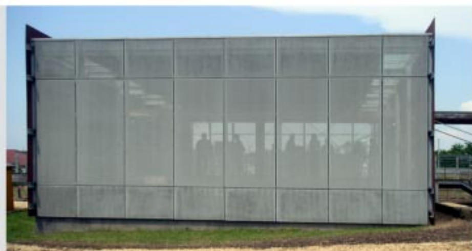
Das Streckmetallgitter sorgt für Witterungsschutz.
